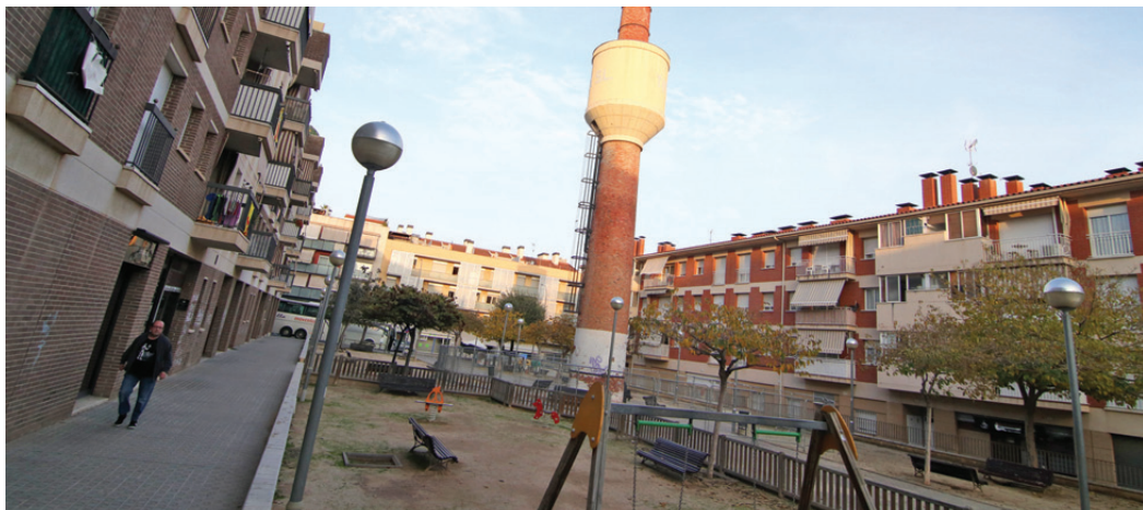
La xemeneia de l'antiga Tintex, protegida per tanques
